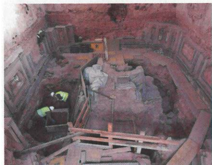
Fig. 8. Detall de les peces procedents del desmuntatge del tabernacle que reblen completament les rases.
