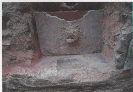
Fig. 6. Vista general de la rasa localitzada al voltant del basament del tabernacle a l'interior del Sagrari.
