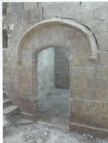
Vista de la porta de la capella gòtica un cop excavada
