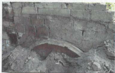
Vista de la porta d'una capella gòtica en el moment de la seva aparició durant l'excavació
