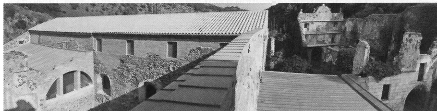
Vista general a nivell de cobertes de l'àmbit on s'ha actuat
