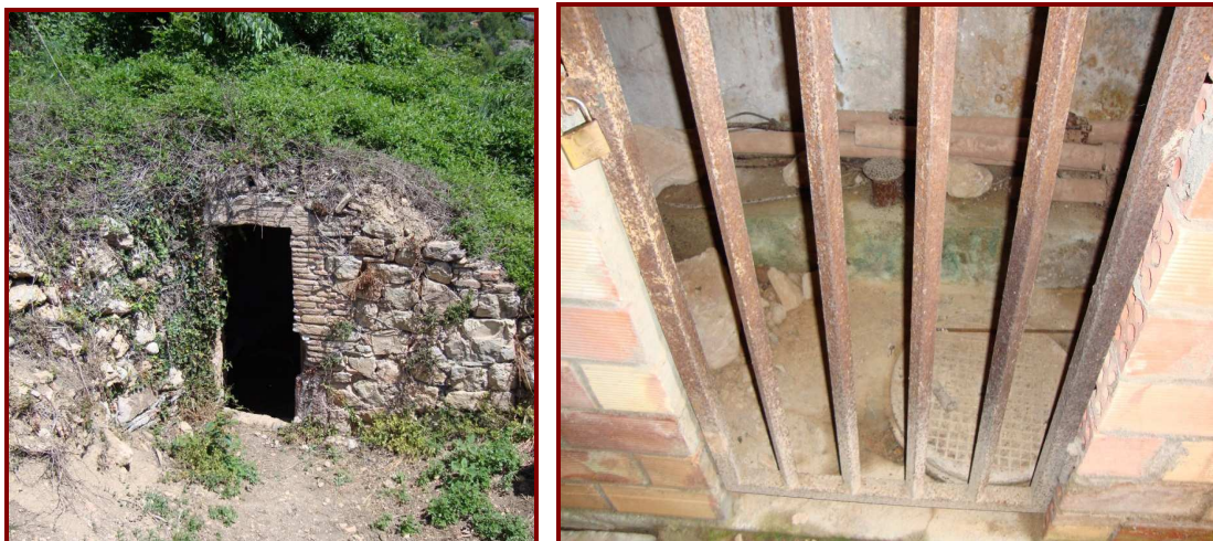
FIG 6. VISTA GENERAL DE LA CAPTACIÓ DE LA FONT MINITRAL
