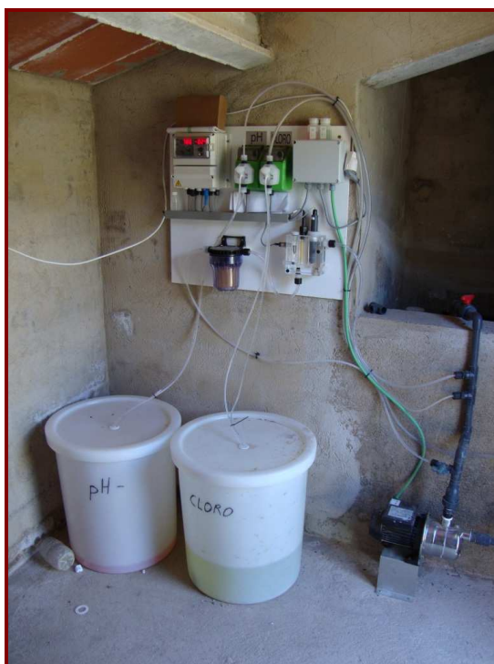
FIG 20. DETALL DE L'ESTACIÓ DE DESINFECCIÓ D'ESCALA-DEI
