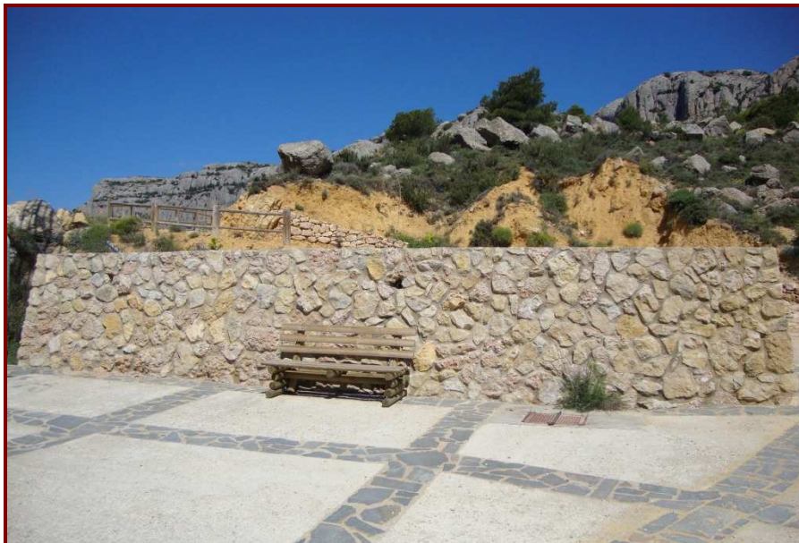
FIG 10. VISTA GENERAL DEL DIPÒSIT ACUMULADOR DE LA MORERA DE MONTSANT
