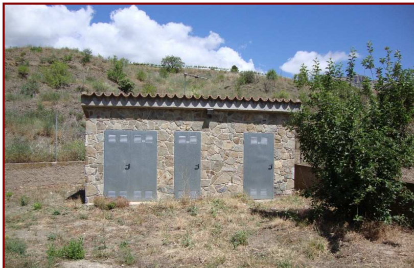
FIG 15. VISTA EXTERIOR DE L'ESTACIÓ DE BOMBAMENT D'ESCALA-DEI
