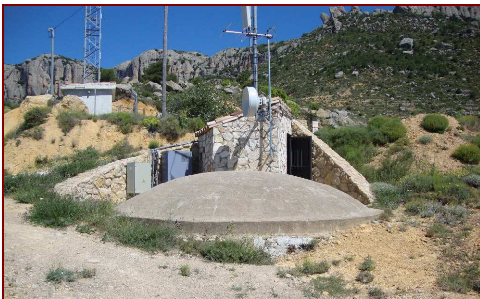
FIG 11. VISTA GENERAL DEL DIPÒSIT PETIT DE LA MORERA DE MONTSANT
