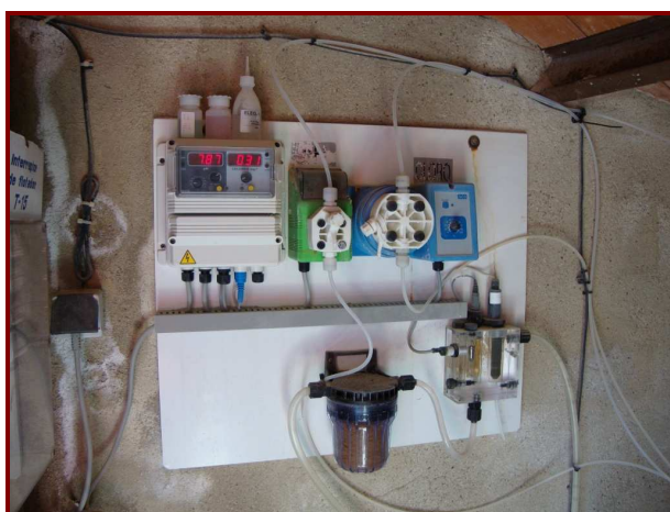
FIG 37. DISPOSITIU D'AUTOANALITZADOR DE CLOR EN CONTINU
