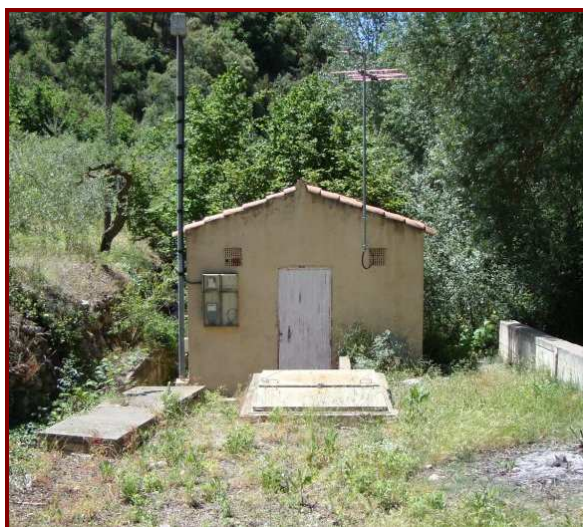
FIG 17. VISTA EXTERIOR DE L'ESTACIÓ DE BOMBAMENT BARRANC DE L'HORTA
