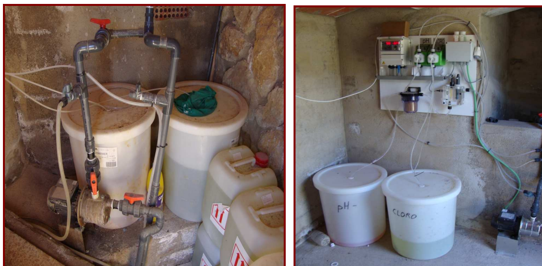
FIG 31. DETALL DE L'ESTACIÓ DE DESINFECCIÓ ACTUAL DE LA MORERA DE MONTSANT I ESCALA-DEI
