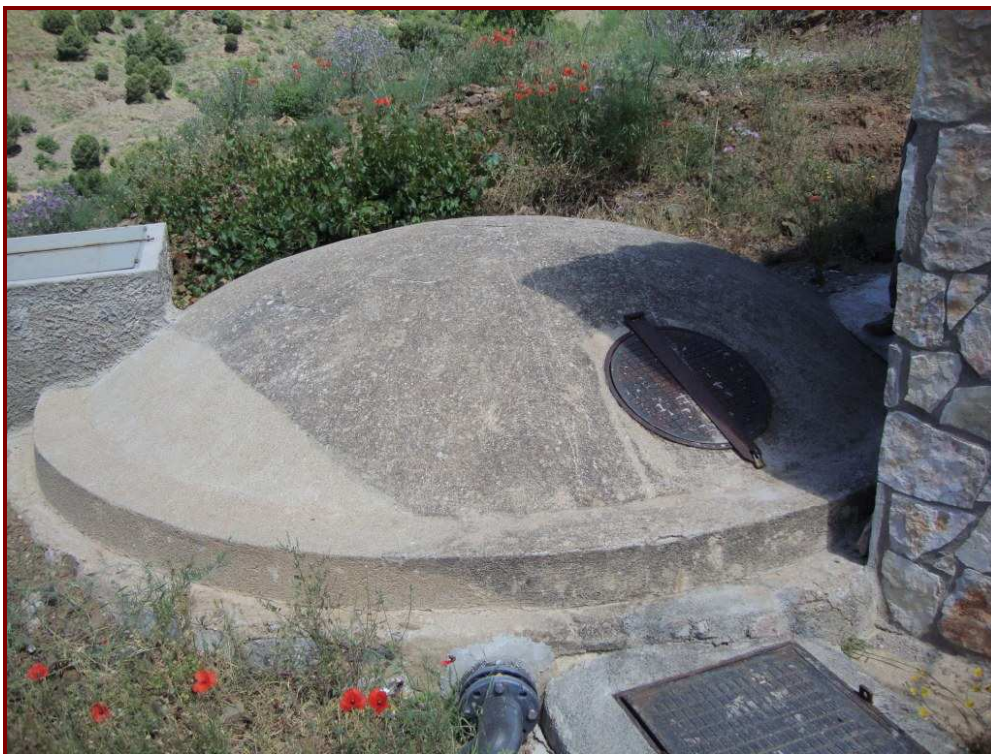
FIG 14. VISTA GENERAL DEL DIPÒSIT PETIT D'ESCALA-DEI
